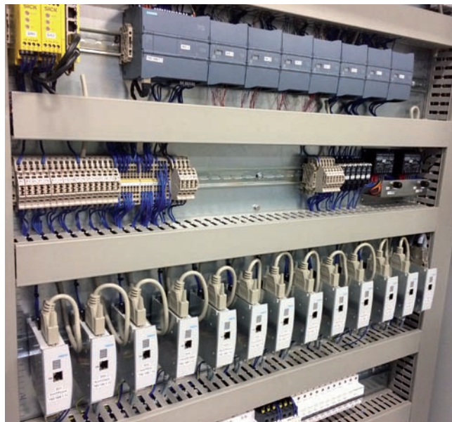
Trinášť elektrických pohonov Festo prepojených s riadiacim systémom Simatic S71200
