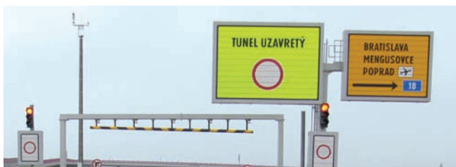
Premenné dopravné značenie upozorňuje vodičov na zmeny v doprave pred vjazdom do tunela.
