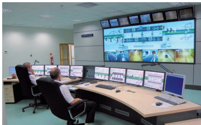
Operátorské pracovisko tunela Bôrik
