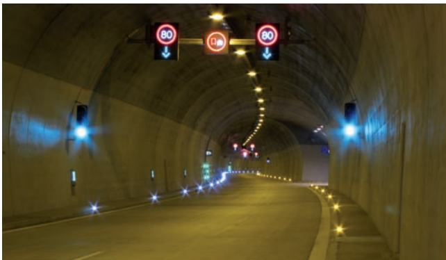
Osvetlenie vjazdových úsekov tunela, tzv. akomodačné pásma, je riešené reguláciou vo viacerých stupňoch.
