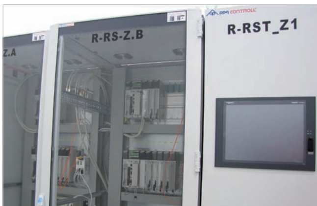
Na najvyššej úrovni riadenia tunela Bôrik je použitý riadiaci systém Modicon Quantum.
